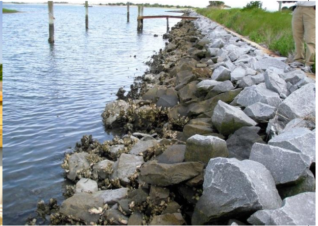
Riprap Revetment
